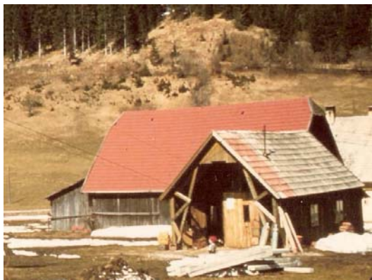
Abbruch der Talstation und der Seilstützen
