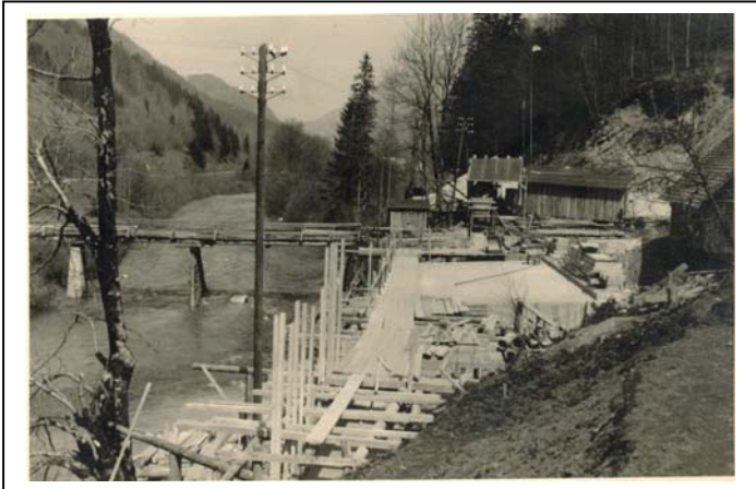
Hochrieß Brückenbau über den Steinbach im Zuge der Verlegung der Straße.
