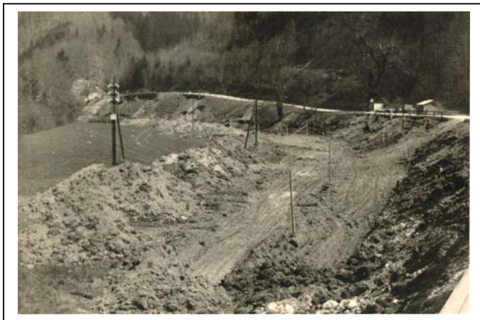
Hochrieß Verlegung der Bundesstraße nördlich des Hauses Ybbssteinbach 10 (Gasthaus Kögerlwirt). Abtragung des Berges und Umlegung der Straßentrasse.
