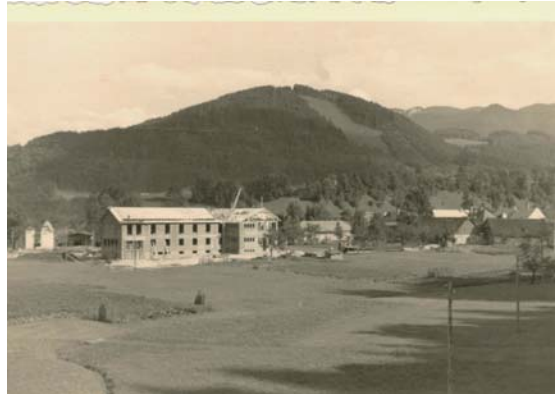
Hauptschule im Rohbau, noch viel leere Fläche ringsum
