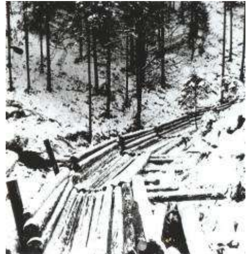
Bauwerk für die Holzbringung in schwierigen Lagen
