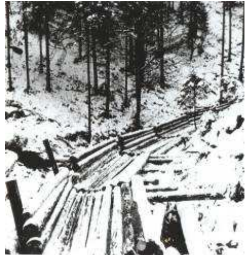
Bauwerk für die Holzbringung in schwierigen Lagen
